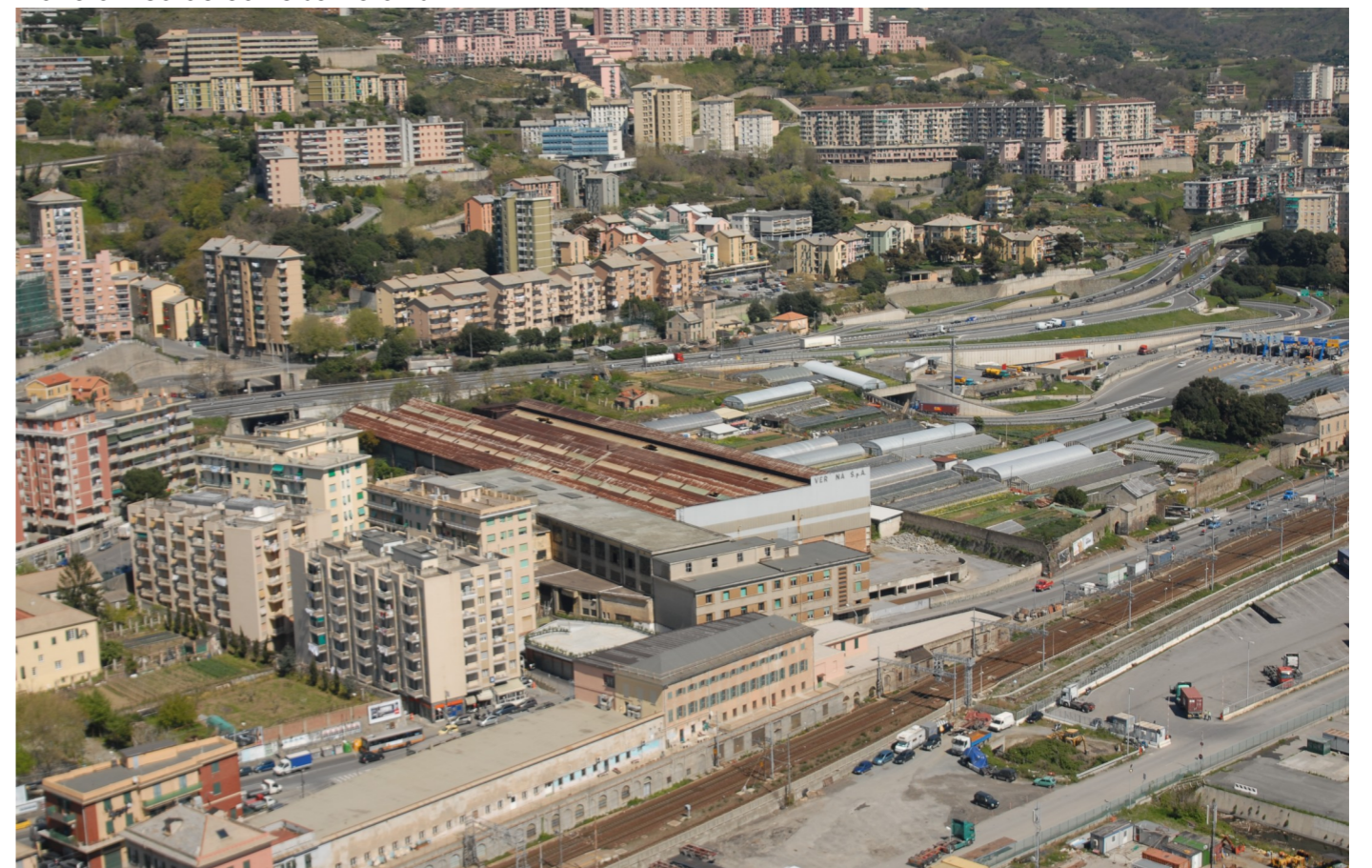
Panoramica aerea verso Nord-Est
